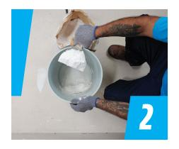
En un recipiente incorporar una parte de agua limpia, luego espolvorear en forma de lluvia dos partes de masilla Jointfiller Infinita sobre el agua y dejar reposar durante dos minutos.
